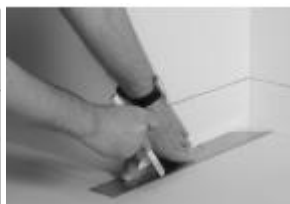
Nanieść podobną linię na podłogę.
